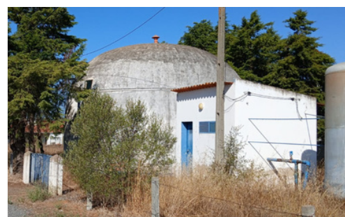
Reservatório de Rio de Moinhos, a reabilitar na empreitada
