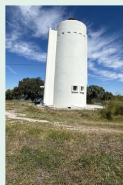
Reservatório da Estrela
