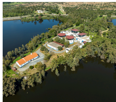
ETA do Monte da Rocha (Ourique)
