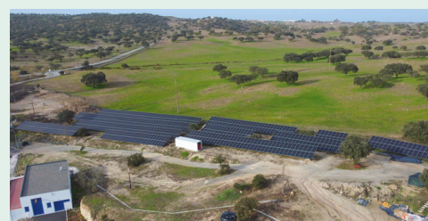
UPAC da ETA da ETA do Enxóé (Serpa)
