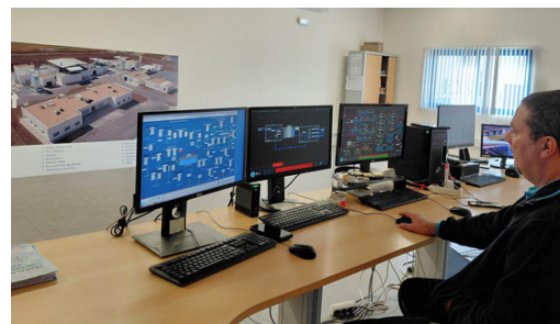
Monitorização através da telegestão
