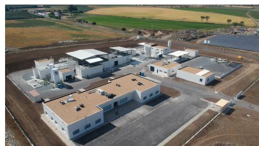
Estação de Tratamento de Água (ETA) da Magra - Salvada, Beja
